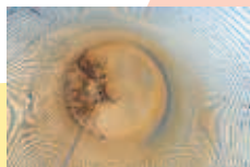
Des dépôts épais se forment souvent sur le fond du silo.
