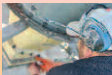
Beim Reinigungssystem Bättig ist neben der Entleerungsöffnung kein weiteres Loch im Silo nötig.
