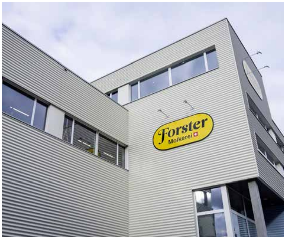
Der im Jahre 2021 eröffnete Neubau der Molkerei Forster. (Foto: © Molkerei Forster)
