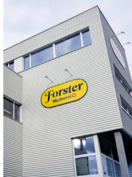
Der Neubau der Molkerei Forster in Herisau.
